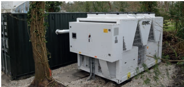
△ De warmtepomp, met in een groene container de technische ruimte.
