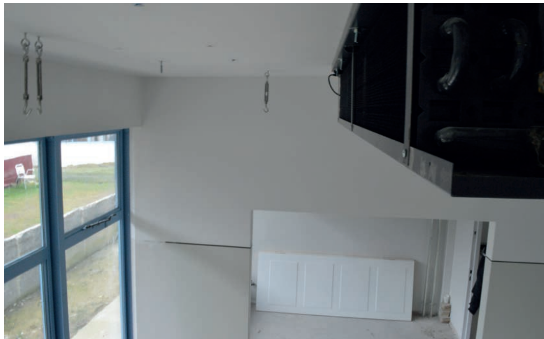
△ De Jaga-convectoren aan het plafond. Het akoestische plafonnetje moet hier nog geplaatst worden.
